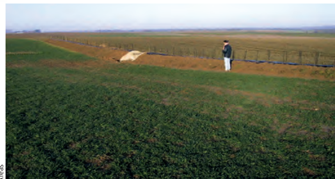
Fig. 13 - Exemple de diguette avec plantation de haie implantée en fond de thalweg.
