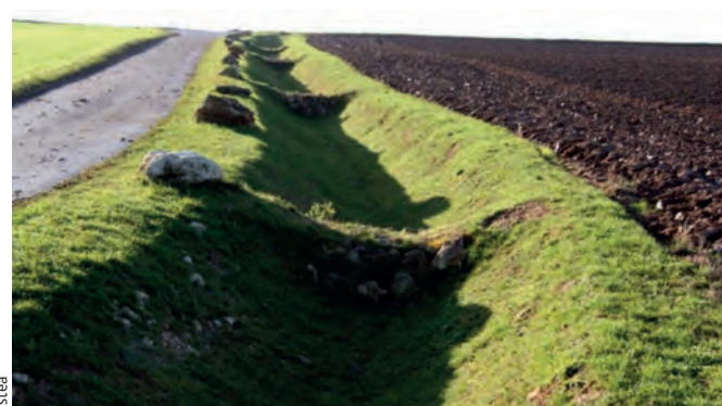
Fig. 15 - Fossé à redents.
