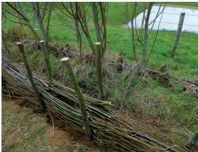
Fig. 12 - Renouvellement d'une fascine.
