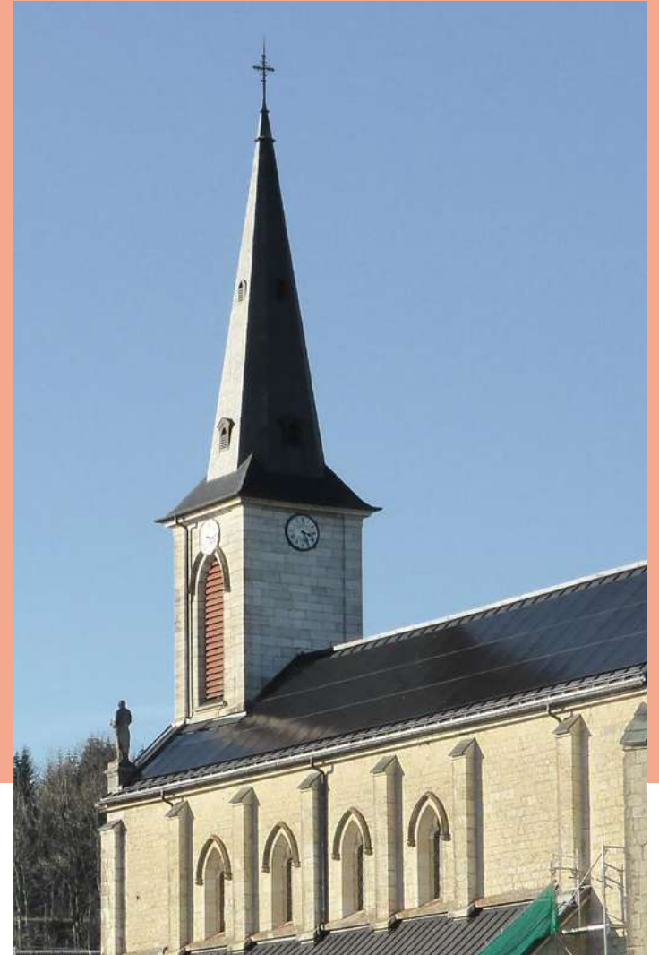
Exemple d'équipement photovoltaïque de l'église de Remoray-Boujeons (25) – © Architectes ZIOUA
