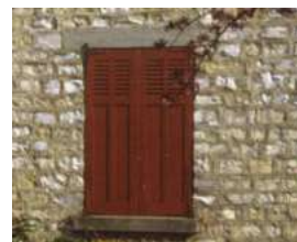
Mur maçonné en pierre meulière
