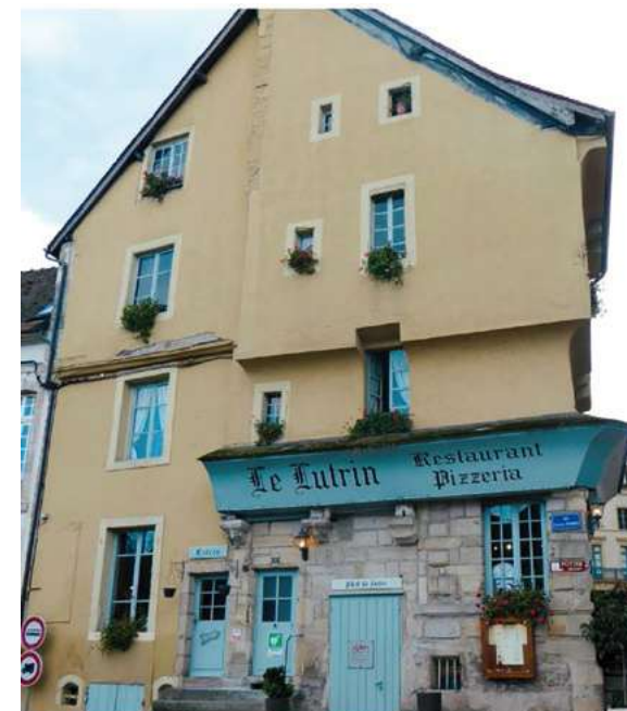
Avant la rénovation
