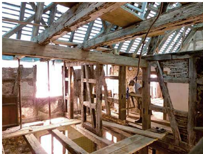
Le plancher du premier étage a été déposé pour permettre une projection continue du béton de chanvre entre les étages – Schnersheim (67) – © CREBA
