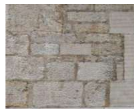
Soubassement en moellons
