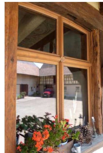
Pose de nouvelles menuiseries en bois avec double vitrage (67) © Denis Elbel – CREBA
