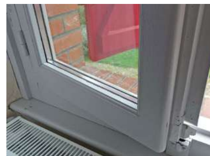
Ci-dessus : pose d'un nouveau vantail avec cadre bois pour recevoir le double vitrage, plaqué contre le vantail existant (survitrage) à Thermes-Magnoac (65) © CREBA
