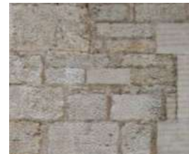
Mur en moellons
