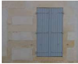
Encadrement de baies en pierre de taille
