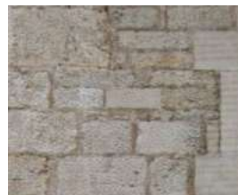
Mur en moellons
