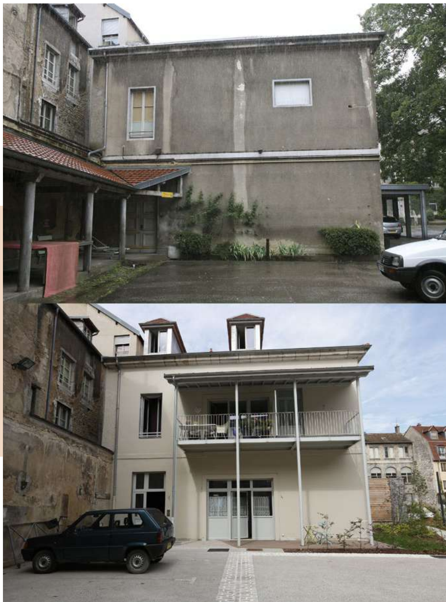
Création de balcons en Site patrimonial remarquable. 6, rue de la Madeleine à Besançon (25) : Lefranc-Corbet-Friant et Tempesta Architectes. © SedD/CEI
