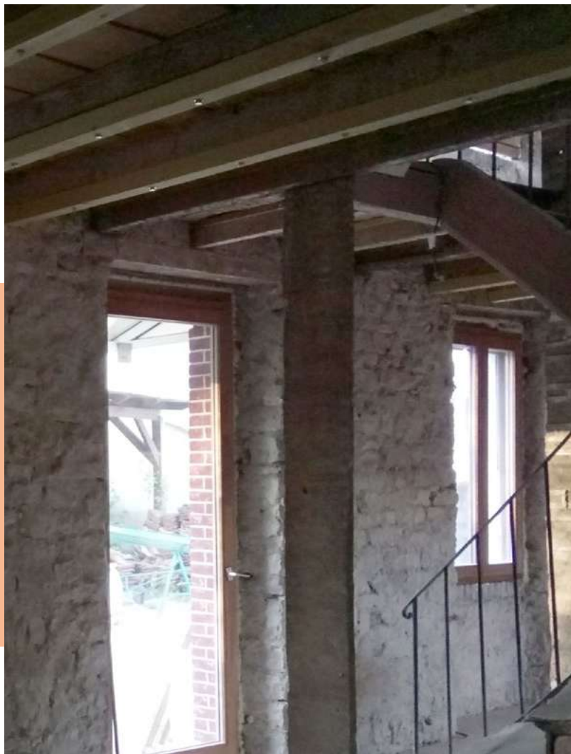
Renforcement de plancher bois avant isolation © Stéphanie Honnert Architecte
