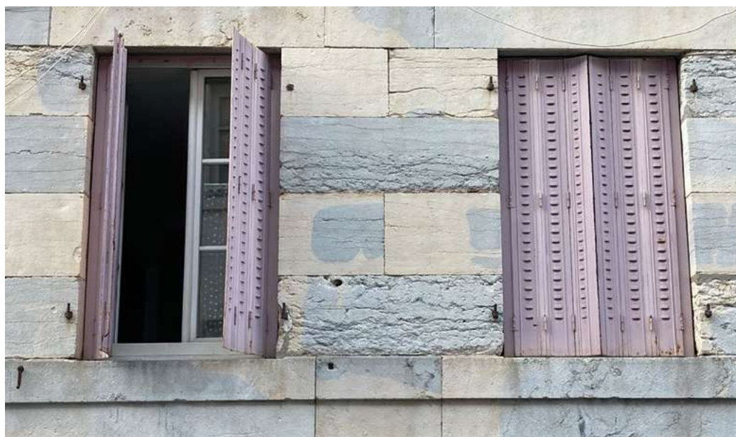
Persiennes métalliques – rue Grand-Charmont à Besançon (25) – © Ajena
