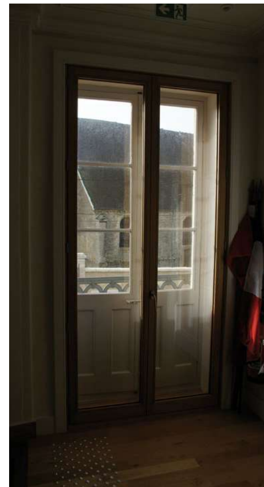
Double fenêtre à Bucey-lès-Gy (39) © Ajena Architecte : Architectures Amiot Lombard
