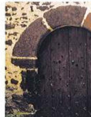
Très dur et imperméable, le grès taillé apparent servait essentiellement à réaliser des sous-bassements et des éléments de structure (A1) ainsi que certains ouvrages défensifs.
