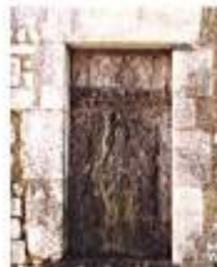
Cette maçonnerie était toujours recouverte d'un enduit sauf dans les constructions les plus modestes où elle était simplement rejointoyée. (C4)
