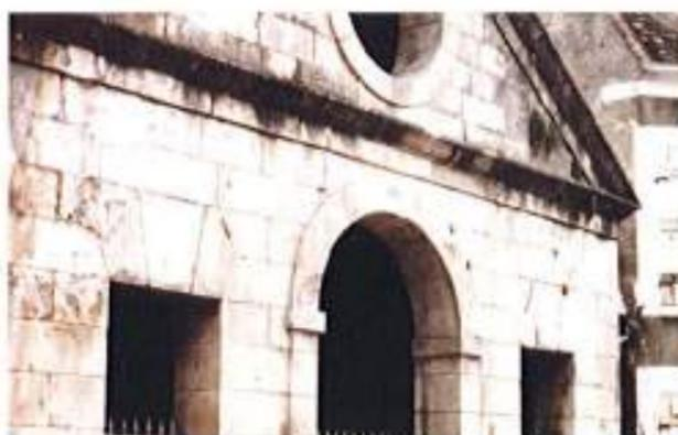
L'appareillage en pierre de taille est constitué de blocs taillés à angles vifs. Ces blocs étaient posés en assises plus ou moins régulières sur un lit de mortier. Ils étaient
