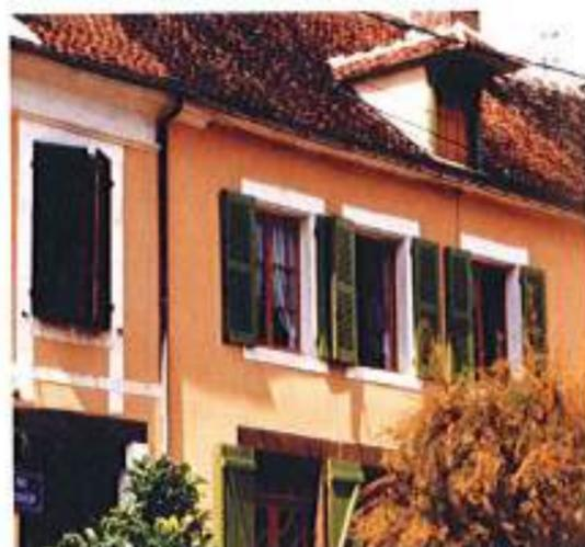
Ces enduits sont le plus souvent associés à des éléments de structure et de modénature appareillés (A2) destinés à rester apparents et qui sont mis en valeur par les enduits.
