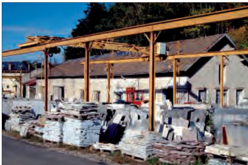
Fig. 8 – Atelier de fabrication de la marbrerie Yelmini Artaud (Balanod). Au fond débitage et polissage, au premier plan atelier des marbriers. (Cliché Y. Sancey © Inventaire général, ADAGP, 1993)
