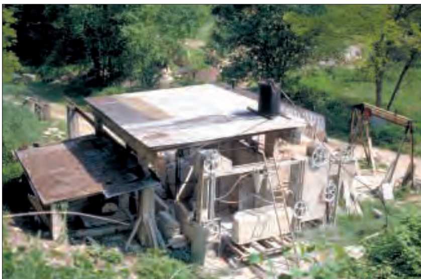
Fig. 16 – L'atelier de Jean Faccenda dans la carrière des Perrières en 1989, rue Xavier Joly à Dole. Au premier plan: installation de débitage au fil hélicoïdal. (Cliché L. Poupard © Inventaire général, ADAGP, 1989)
