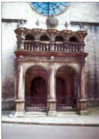
Fig. 21 - Vue générale du portail Renaissance du collège de l'Arc à Dole. (Cliché J.-P. Sizun)
