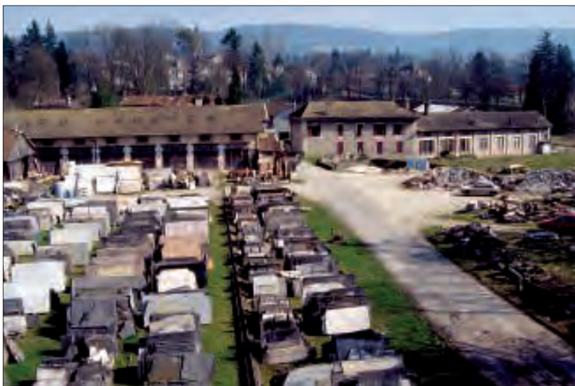
Fig. 6 – Vue d'ensemble de l'ancienne marbrerie Célarde, actuellement Yelmini Artaud (moulin Febvre, Saint-Amour). Scierie de marbre (vers 1897, à gauche), ancien logement patronal et atelier des marbriers (réparation et bureau; vers 1887, à gauche). (Cliché Y. Sancey © Inventaire général, ADAGP, 1994)
