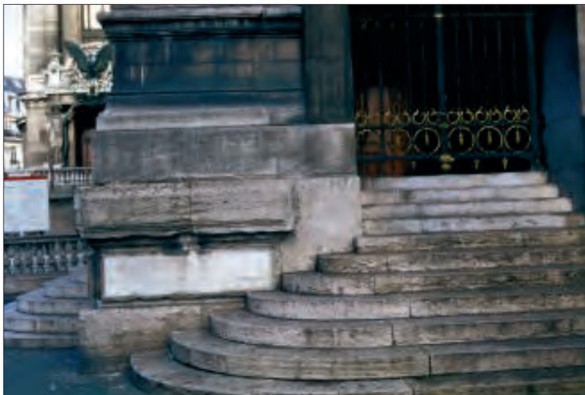
Fig. 2 – Paris, Opéra, soubassement. Sous un groupe sculpté, deux assises en calcaire de Saint-Ylie sous le calcaire oolithique de Bourgogne (Ravières). (Cliché A. Blanc)
