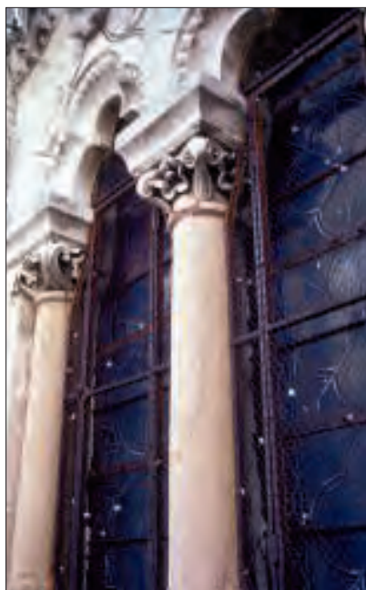
Fig. 10 – Ars-sur-Formans (Ain), basilique du Saint-Curé. Fenêtres du chevet avec colonnes monolithes en calcaire rouge du Jura et coulures. (Cliché Ph. Bromblet)
