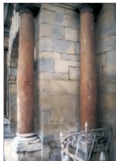
Fig. 18 – Colonnes rougeâtres de marbre de Sampans (faciès « grain d'orge ») contrastant avec les pierres bicolores de la « Grande Oolithe », à l'entrée du Palais de justice de Besançon. (Cliché J.-P. Sizun)
