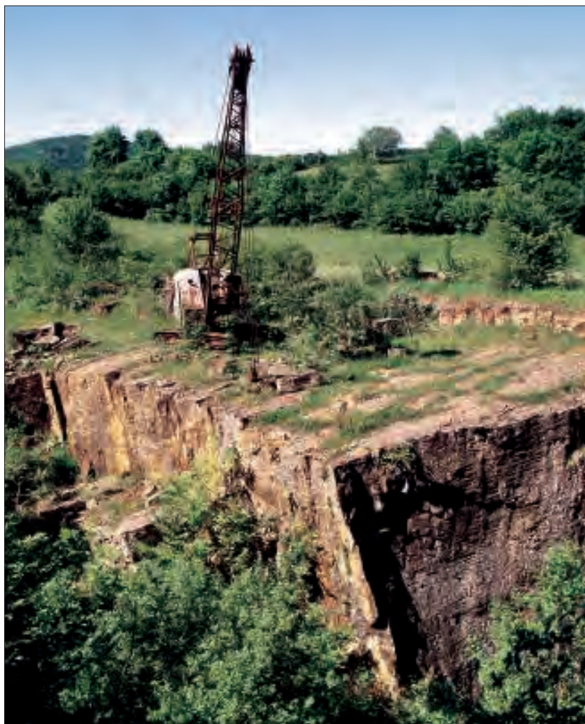
Fig. 9 – Vue d'ensemble de la carrière des Carrats (Graye-et-Charnay, Jura). La grue a été installée vers 1971 pour faciliter l'évacuation des blocs. (Cliché Y. Sancey © Inventaire général, ADAGR, 1997)
