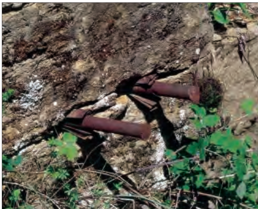
Fig. 9 – Coins et « joues » (tiges plates métalliques facilitant le jeu des coins) enfoncées dans une fissure du banc de marbre. (Cliché Y. Sancey © Inventaire général, ADAGP, 1997)
