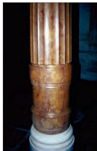
Fig. 7 – Paris, Opéra, intérieur, Rotonde des Abonnés. Colonnes monolithes, cannelées et baguées en calcaire rouge de Sampans (Jura). (Cliché A. Blanc)
