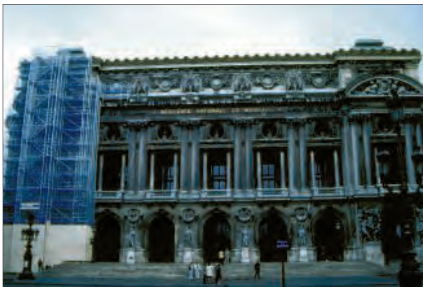
Fig. 1 - Paris, Opéra, façade avec échafaudage d'étude. (Cliché A. Blanc)
