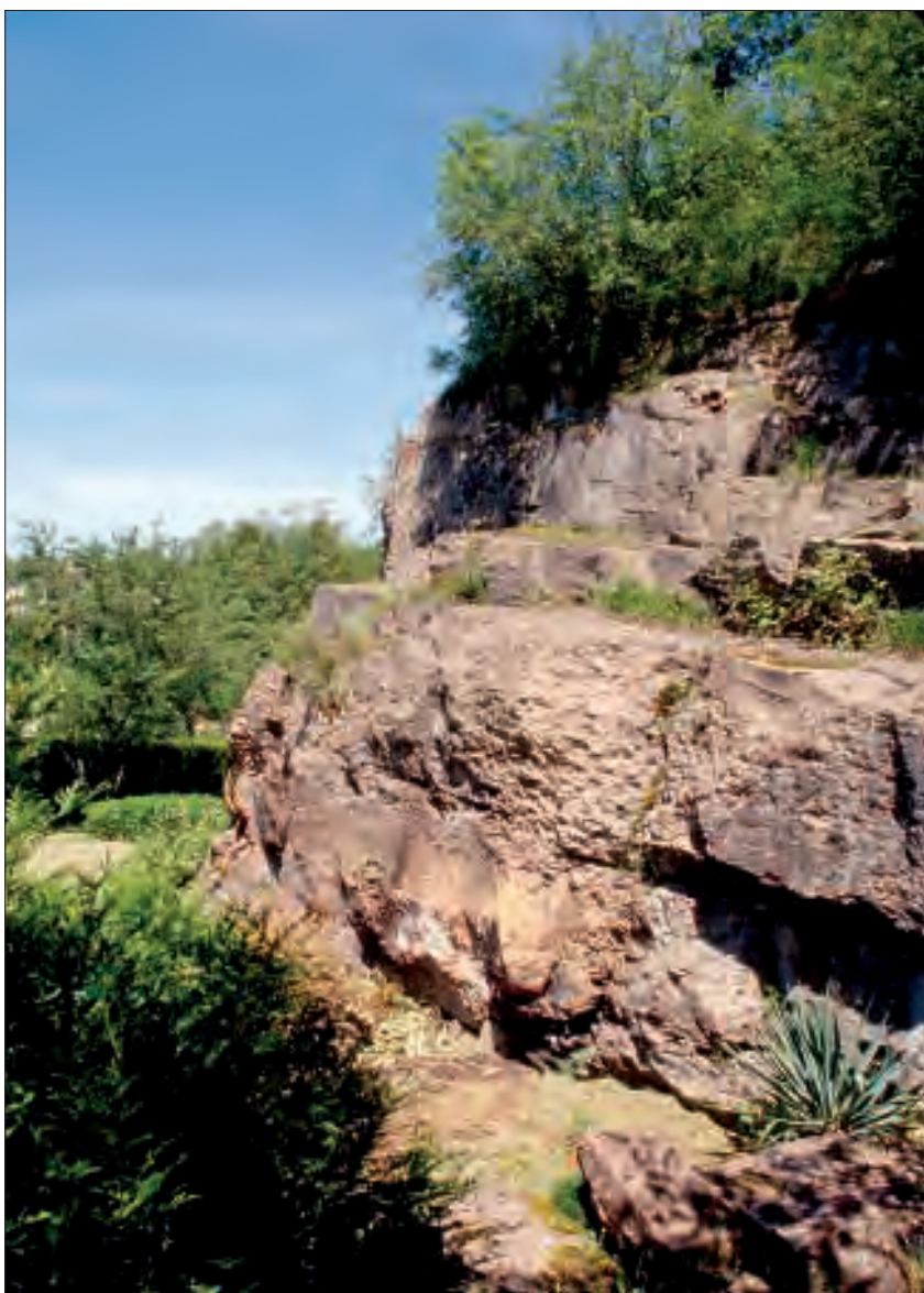
Fig. 10 – Détail du front de taille de la carrière des Escherolles (Bajocien supérieur), Sampans. (Cliché Y. Sancey © Inventaire général, ADAGP, 1997)
