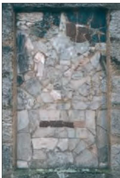
Fig. 2 – Besançon (Doubs), Square Castan. Assemblage moderne d'éléments antiques; en haut, groupement de roches ignées: porphyre rouge, porphyre vert dit de Sparte, labradorite...; au centre, brèches calcaires amygdalines. (Cliché J.-C. Barçon)
