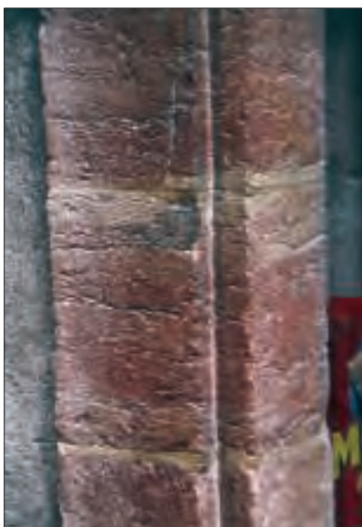
Fig. 25 – Pierre d'angle réalisée en calcaire de Sampans (faciès bioclastique) dont la surface a été travaillée à la boucharde, au n° 25 Grand Rue, à Dole. Noter l'importance des joints dans la pierre placée ici en lit. (Cliché J.-P. Sizun)
