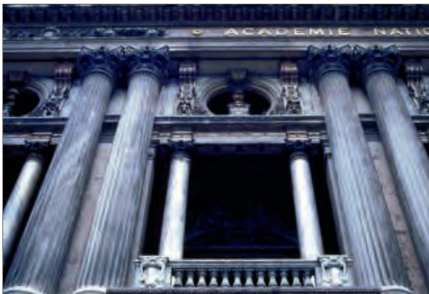
Fig. 3 – Paris, Opéra, façade. Présence de calcaire rouge du Jura entre les colonnes monolithes cannelées. (Cliché A. Blanc)
