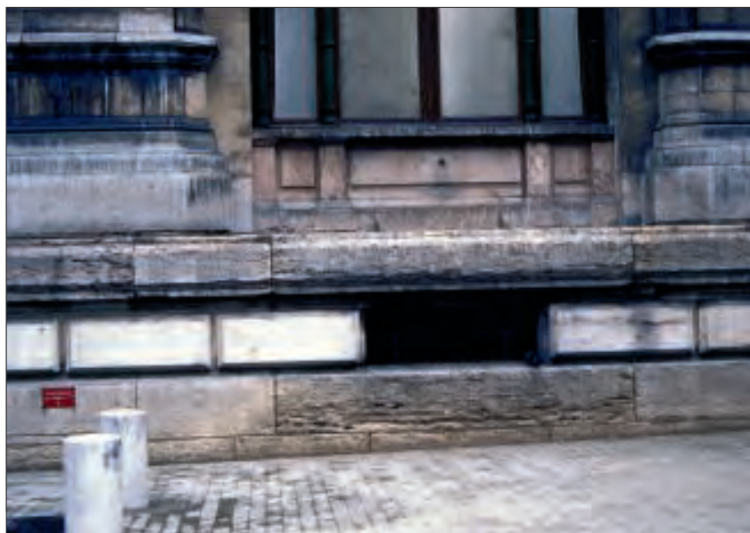
Fig. 5 – Paris, Opéra, côté rue Auber. Calcaire de Saint-Ylie en soubassement, calcaire rouge au-dessus. (Cliché A. Blanc)
