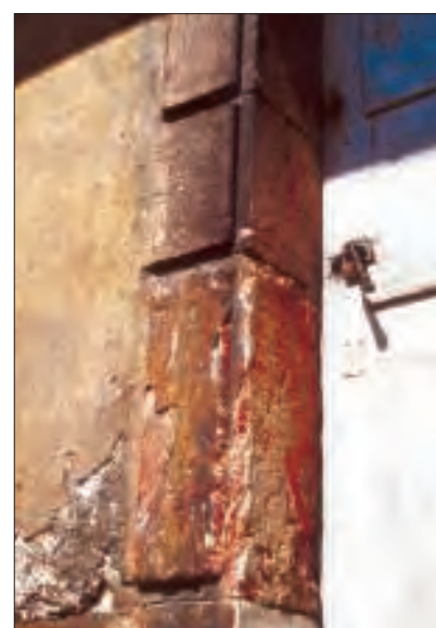
Fig. 26 – Développement de plaques sur le calcaire de Sampans (Sampans, route de Besançon). (Cliché J.-P. Sizun)
