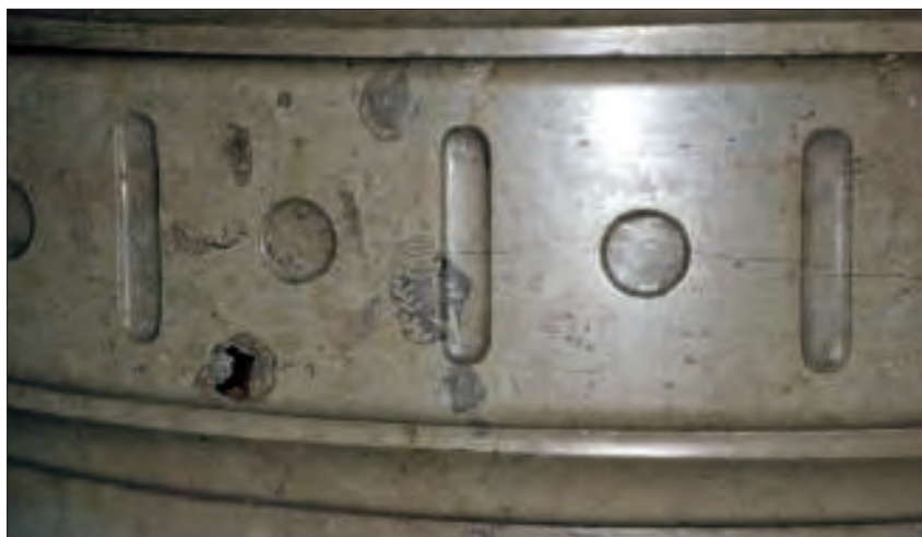
Fig. 14 – Pierre du Jura (« Séquanien ») mise en œuvre pour l'un des colonnes de l'église de la Trinité (Paris, Théodore Ballu, 1861-1867). Ce détail de la bague sculptée ornant le tiers inférieur de la colonne permet de distinguer une section de coquille de gastéropode. (Cliché L. Poupard © Inventaire général, ADAGP, 2001)
