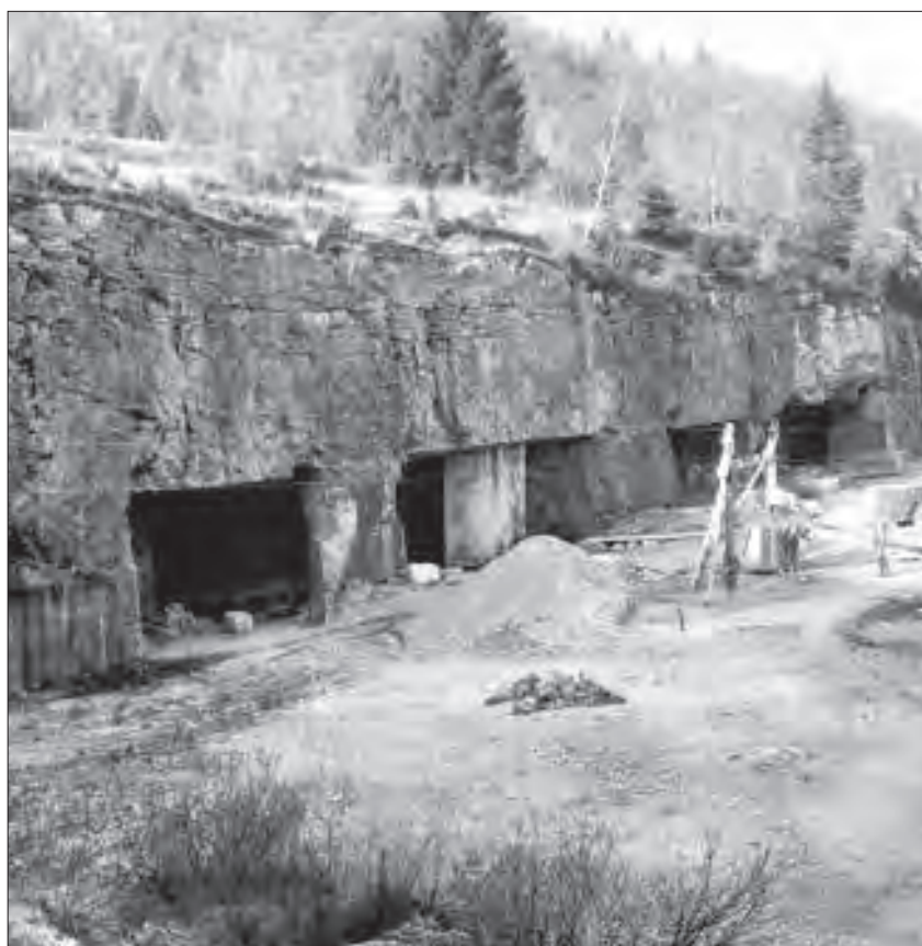
Fig. 11 – Chassal (Jura). Entrées de la carrière souterraine et installation de débitage en 1958. (Collection particulière; reproduction Y. Sancey © Inventaire général, ADAGP, 1997)
