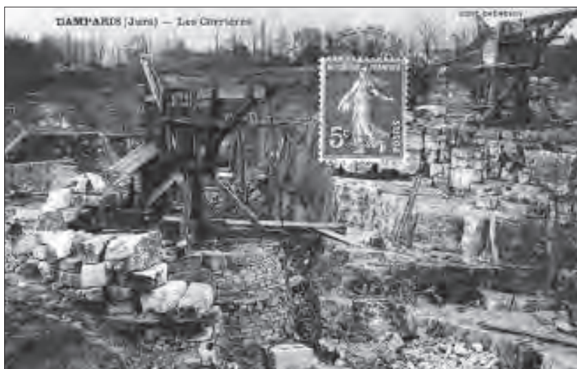
Fig. 13 - Grue en bois actionnée par une machine à vapeur, « trou de la grue » à Damparis. Carte postale, s.d. [fin XIXe siècle - début XXe siècle]. Chenevoy éd. (Archives communales, Damparis). (Reproduction Y. Sancey © Inventaire général, ADAGP, 1989)
