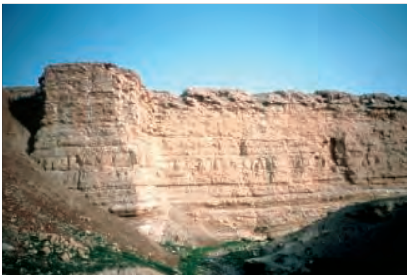
Fig. 10 – Extraction liée à la confection rupestre de la base des remparts hellénistiques de Doura-Europos (Syrie). (Cliché J.-C. Bessac)
